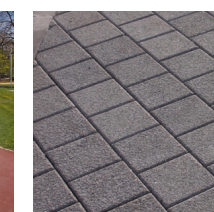
Betonová dlažba 20x20
